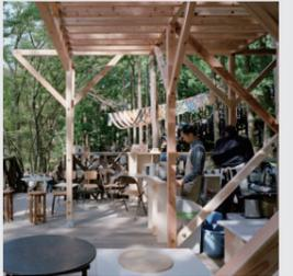
「山武の資材小屋」移動、交換、解体が容易な木の構造体の小屋が、ユーザー主体によるセルフビルドによっても構築可能な構法により実現された。
